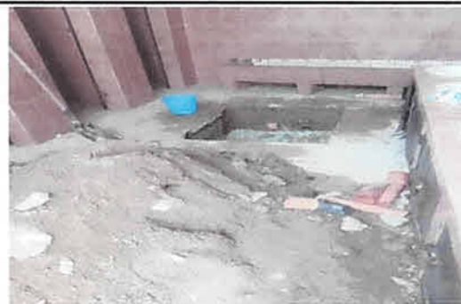
Foto 4: Implementación de nueva tubería en baños,
