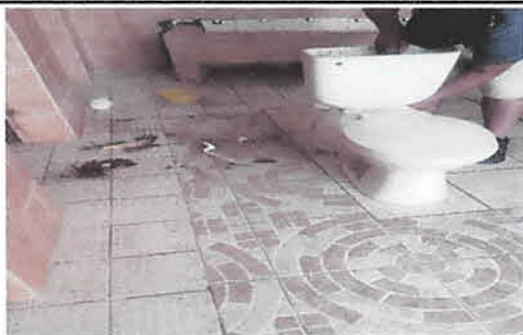
Foto 5: Tazas del baño en reparacion.
