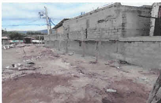
Foto 3: Muro perimetral fundimiento de columnas
