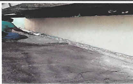
Foto 6: Tubería en mal estado de la bajada de agua, mejorada.
